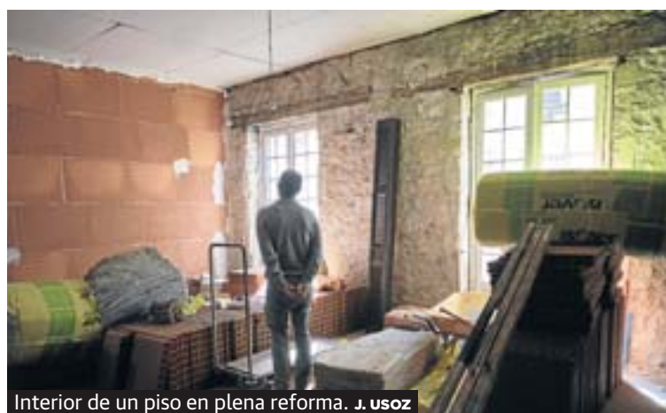
Interior de un piso en plena reforma. J. USOZ
